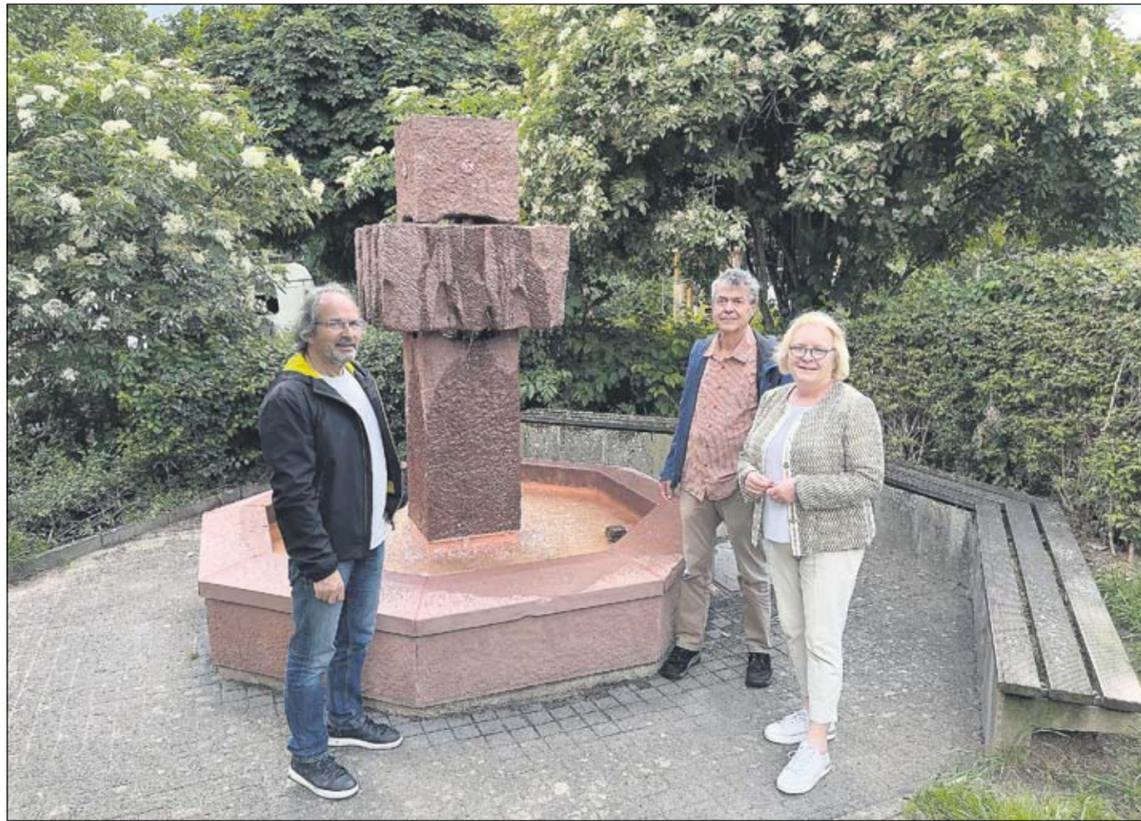
Ein Meisterstück strahlt in neuem Glanz: Der Sandsteinbrunnen an der Schlossstraße in Auerbach ist umfangreich aufgearbeitet worden. Die Anlage war stark verkalkt. Eine Fachfirma im Auftrag der Stadt entfernte nicht nur die bis zu einem Zentimeter dicke Kalkschicht, sondern erneuerte außerdem die Fugen. Darüber hinaus benötigte das Wasserbecken eine
